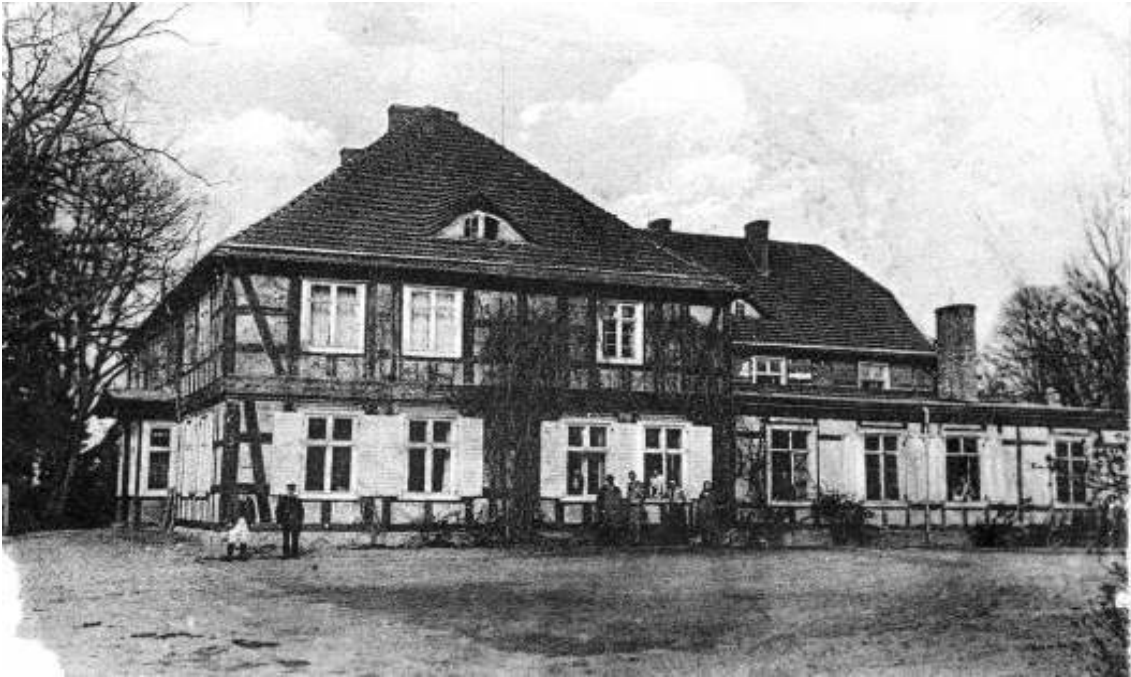
Ansicht von der Zufahrt mit Küchenanbau und Fledermausgauben von 1908, Zustand 1923. Regenrinne verläuft in der Dachebene (soll längerfristig wieder so erfolgen). Kletterrosen. Quelle: Güssow.
