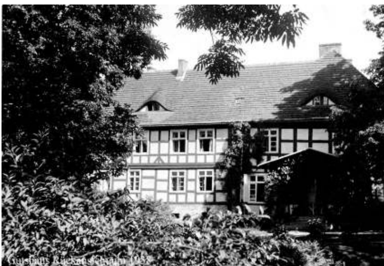
Parkfassade nach der Sanierung 1938.
