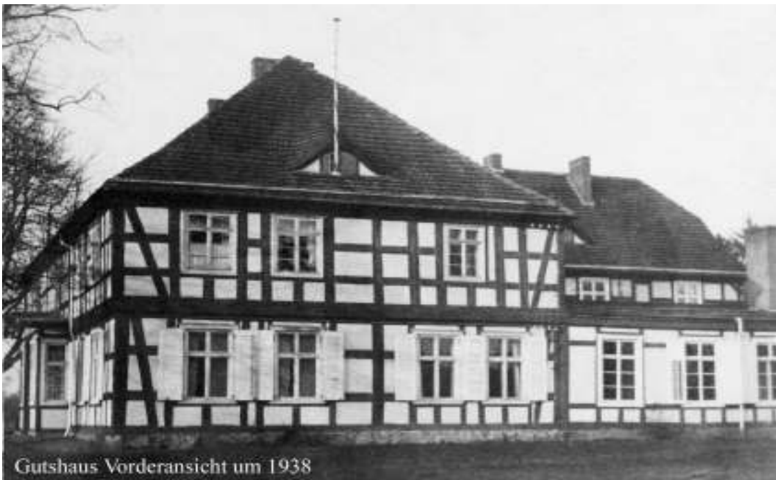
Zustand 1938 nach der Fassadensanierung – mit Fahnenstange.
